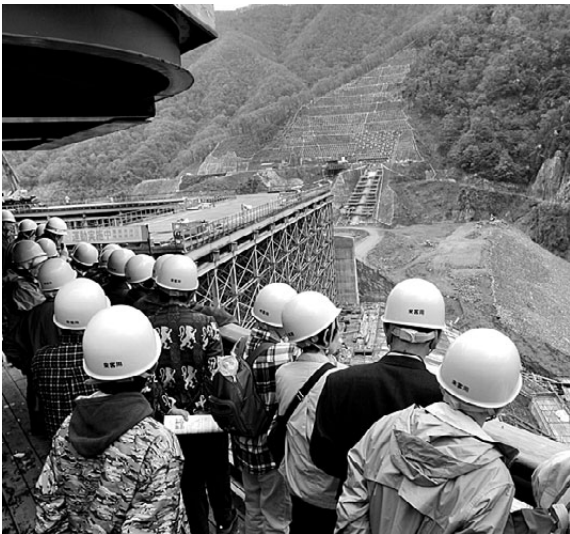
建設中のダムを見学する参加者
