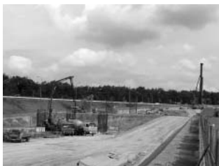
東部丘陵線の工事現場
